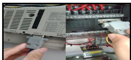
Gambar 6. Pemasangan Kabel RS232 HMI ke PLC
