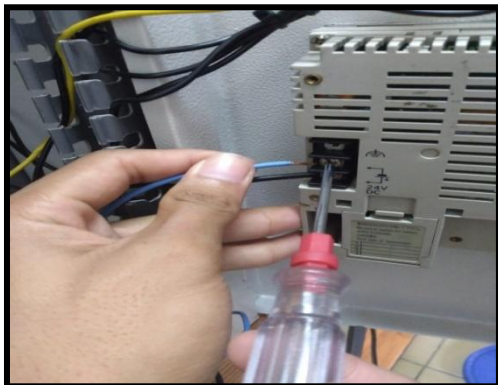
Gambar 7. Pemasangan Sumber Tegangan HMI
